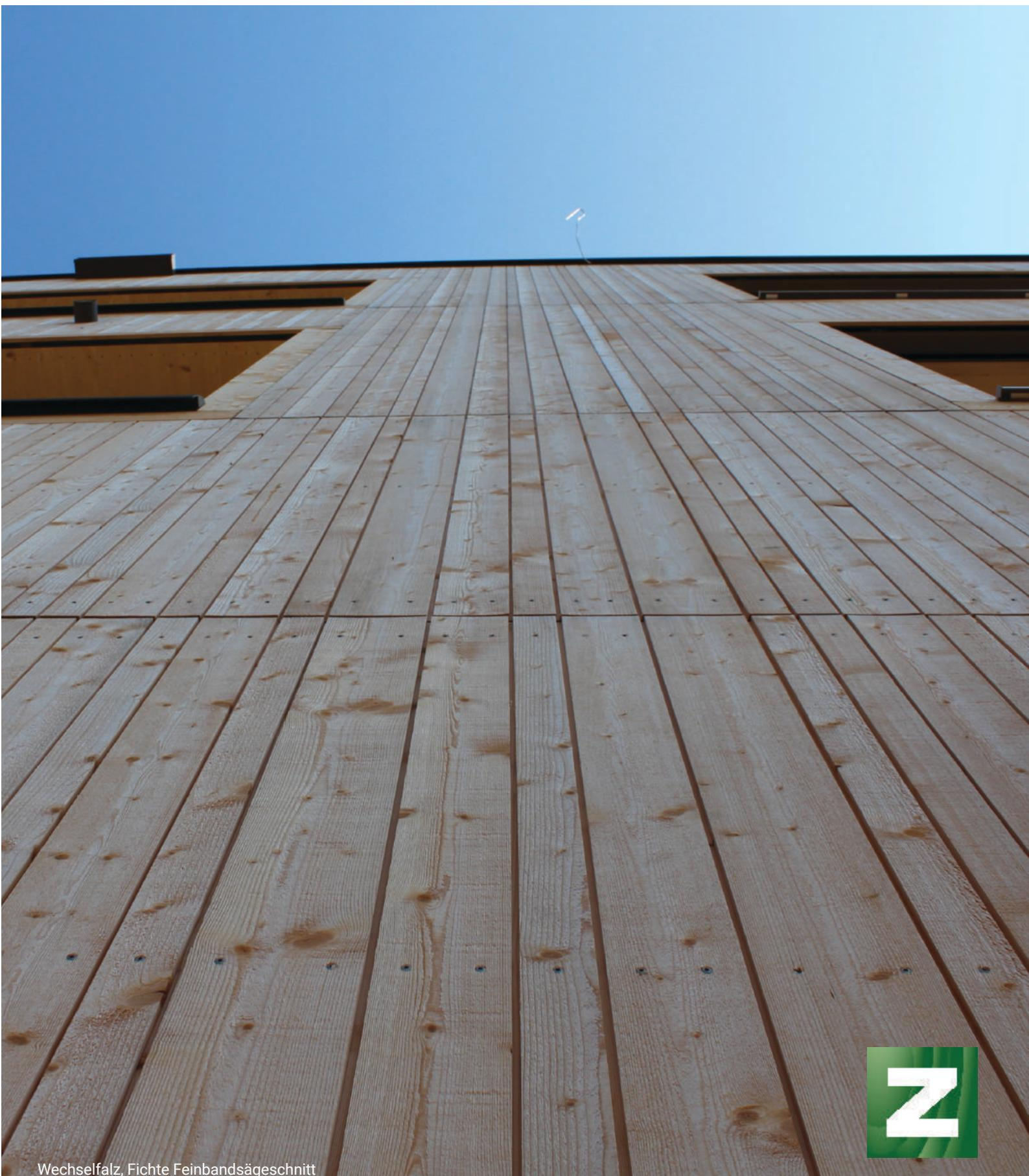
Wechselfalz, Fichte Feinbandsägeschnitt
